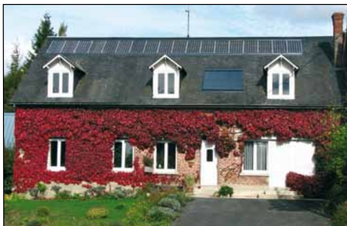
ENERGIES ET TECHNIQUES
