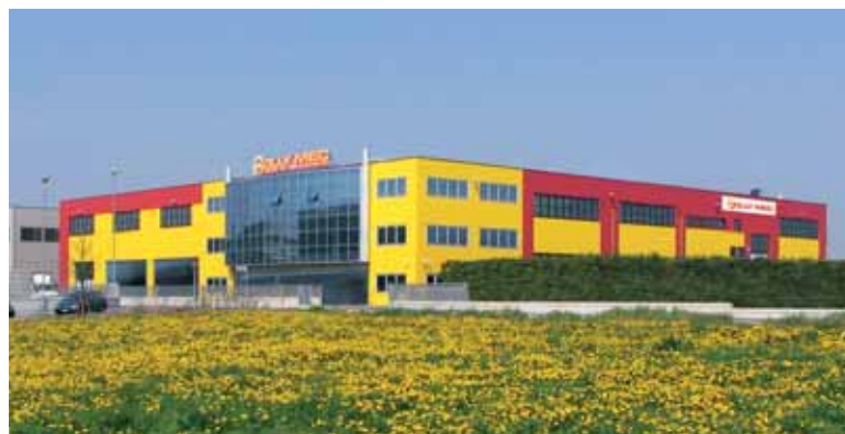
LO STABILIMENTO PRODUTTIVO JOLLY-MEC SI TROVA A TELGATE, NELLA PIANURA BERGAMASCA L'USINE JOLLY-MEC EST SITUÉE À TELGATE, DANS LA CAMPAGNE BERGAMASQUE
